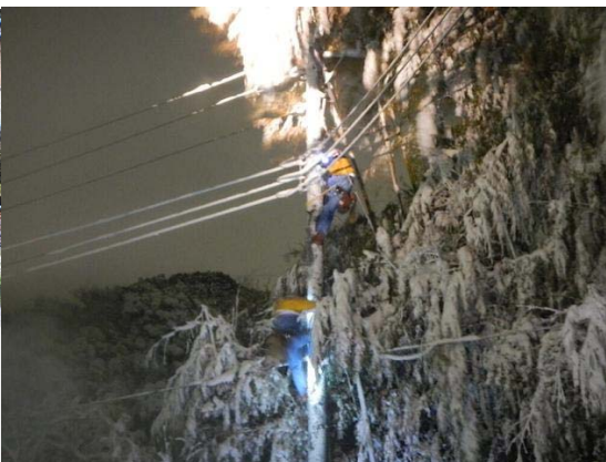
図A6－2配電復旧作業風景
