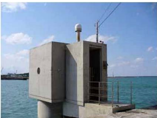
図2-1 潮位観測施設例
