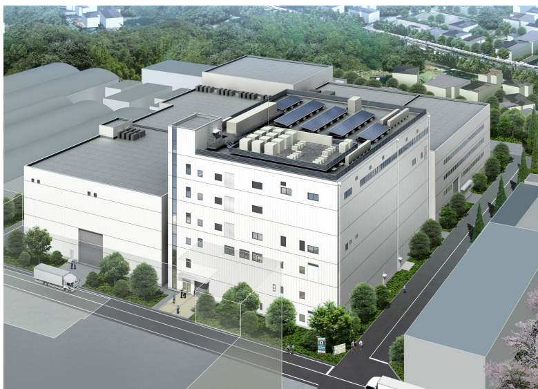
図1 新衛星生産棟外観
