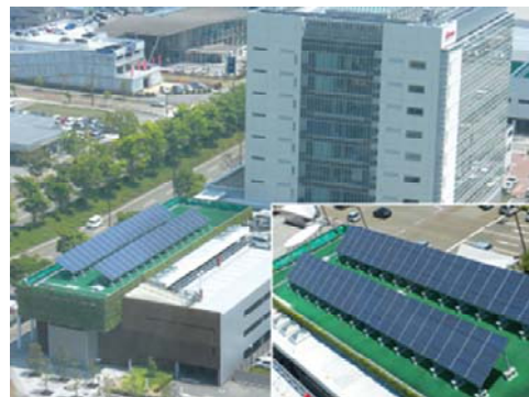
出力電力容量104kWシステム ( http://www.mitsubishielectric.co.jp/service/taiyo/sangyo/case/company/docomo_hokuriku/index.html を参考に作成)
