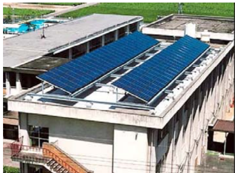
出力電力容量20kWシステム ( http://www.mitsubishielectric.co.jp/service/taiyo/sangyo/case/school/ele_kiyone/index.html を参考に作成)
