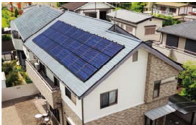
出力電力容量4kWシステム ( http://www.sharp.co.jp/catalogdownload/btoc/sun/sunvista/catalog.pdf を参考に作成)
