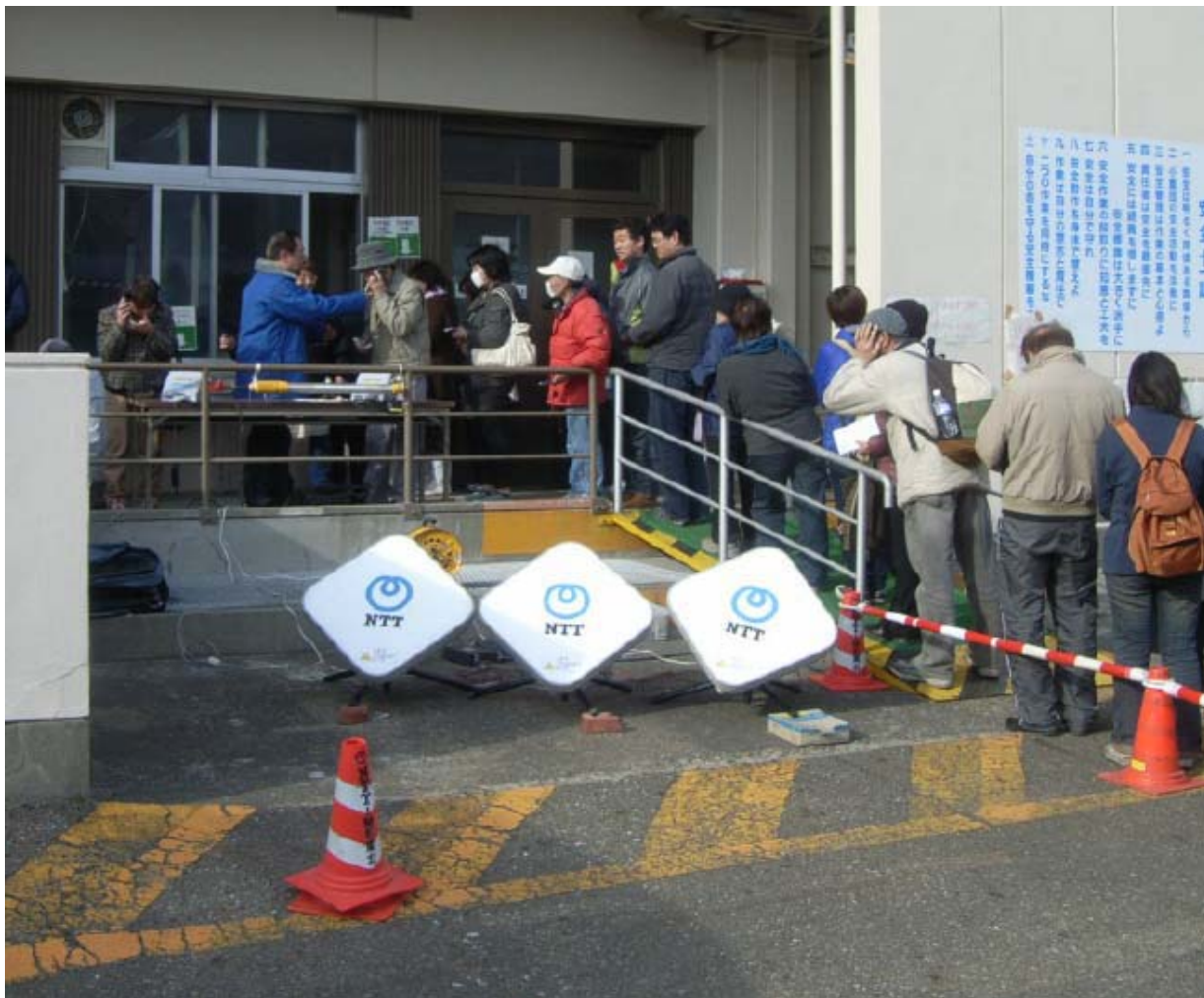
図2 避難所に設置されたKu 帯小型衛星システム (NTT東日本提供)
