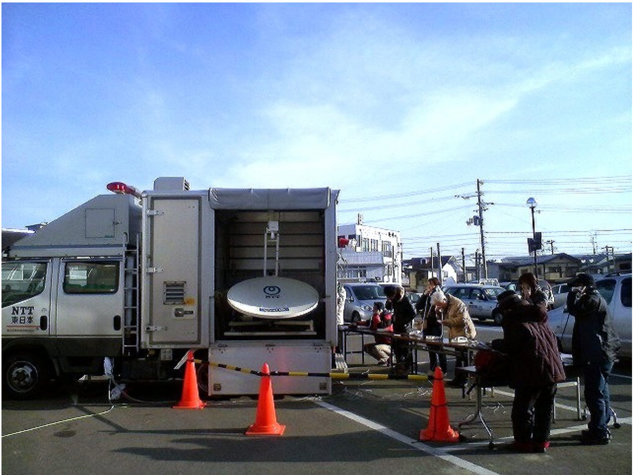
図4 ポータブル衛星通信システムの利用の様子（NTT東日本提供）
