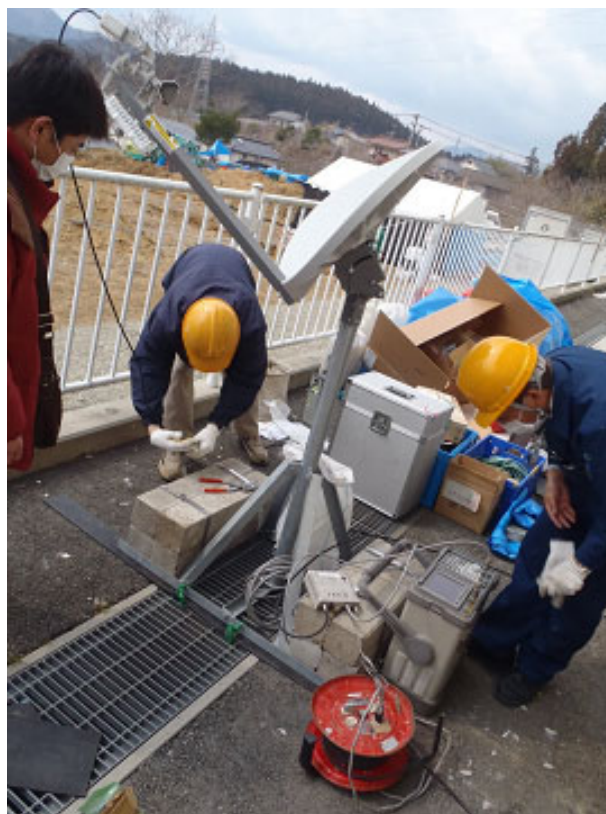
図4. ExBird工事の様子
