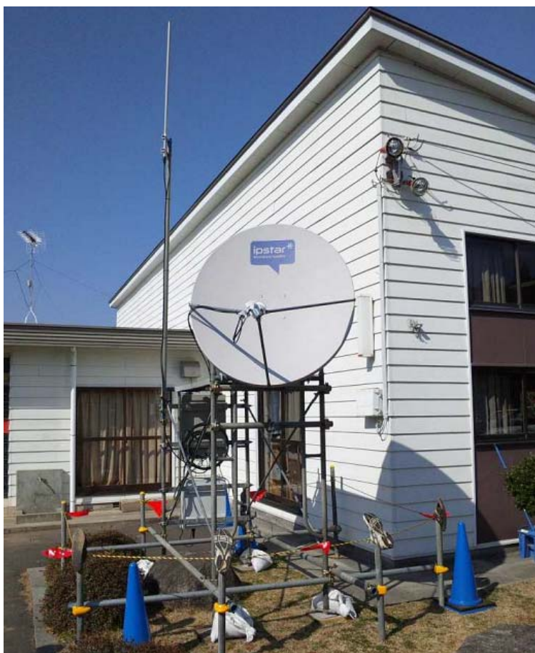
図6 臨時屋外局(アンテナ高6m)
