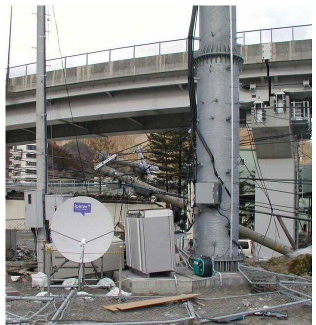
図2 既存局への衛星アンテナ適用例
