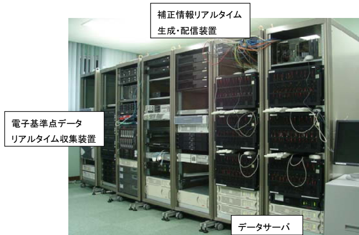
図7 補正情報リアルタイム生成・配信システム外観図
