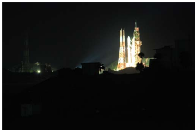
Fig1-3: 射場に据え付けられたロケット
