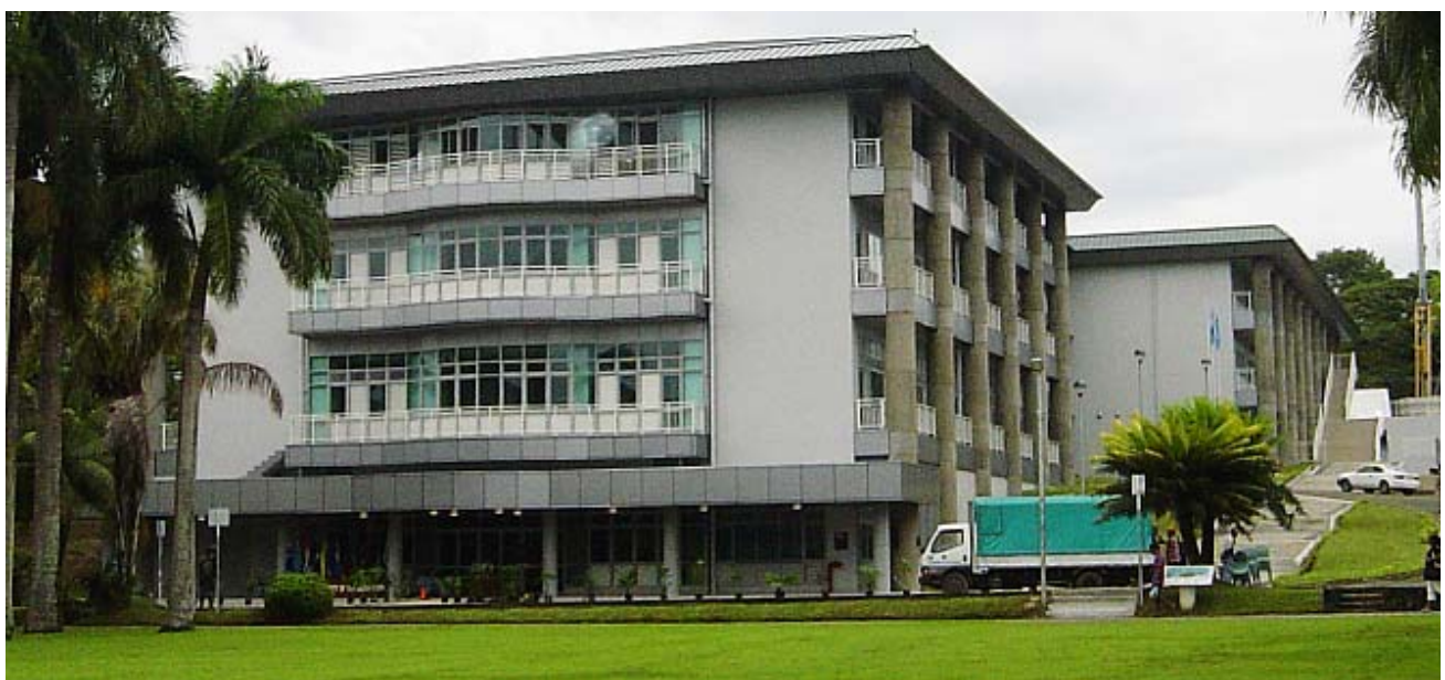
図6 第1期工事が完了したJICA ICTセンター(南太平洋大学スバ)
