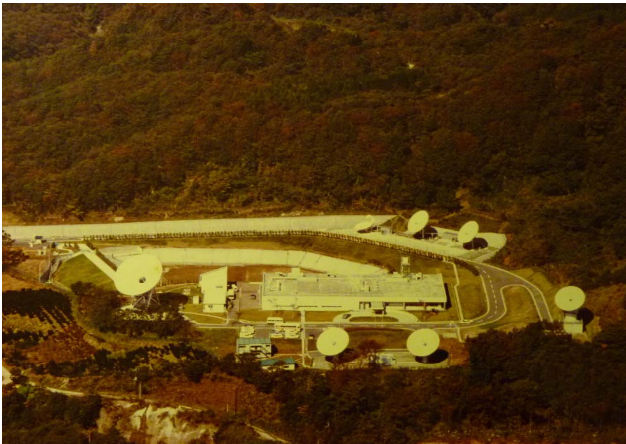
▲ 通信・放送衛星機構 君津衛星管制センター
