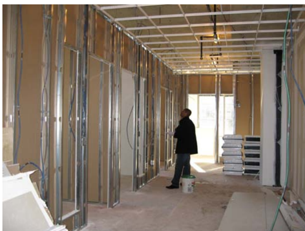
▲ JIIオフィス工事中
