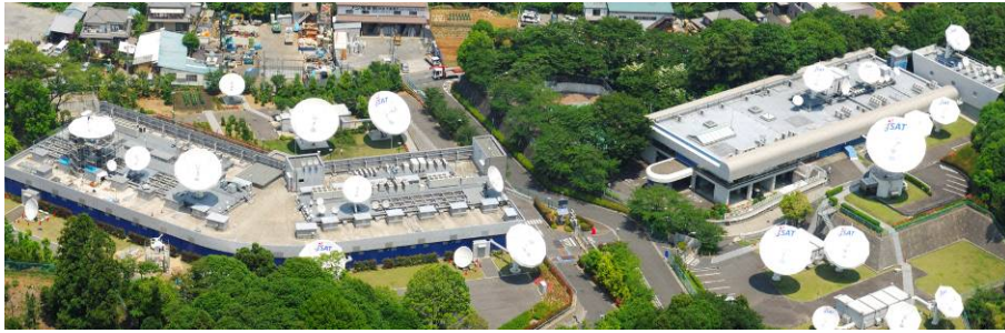
Fig 2. ゲートウェイ地上局設備@YSCC(スカパーJSAT 横浜衛星管制センター)
