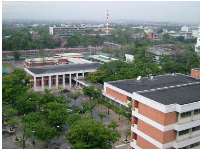
▲モンクット王工科大学工学部(遠方の塔は電気通信工学科建物の屋上に設置されている)
