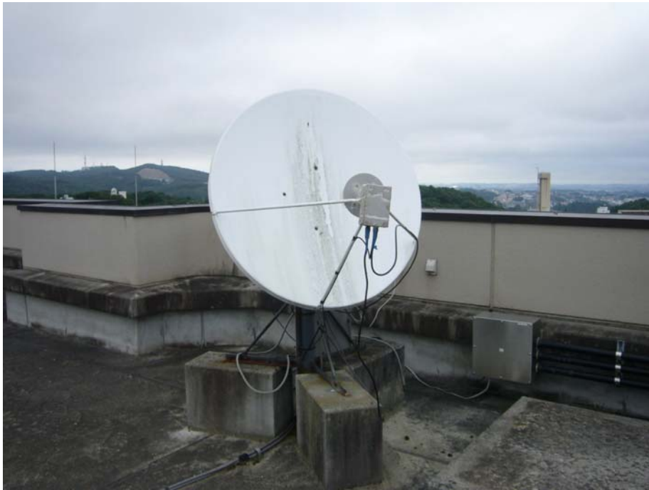
図1 東北大学に設置された ETS-V の地球局のアンテナ
