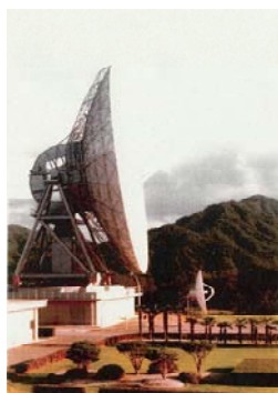
▲山口TTC&M局アンテナ (楕円偏波率: 0.2dB以下を実現)
