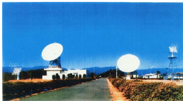
VHF送信 C/L 共用TT&C Lバンド海事衛星 VHF受信 ▲茨城（MARECS）TT&C地球局アンテナ
