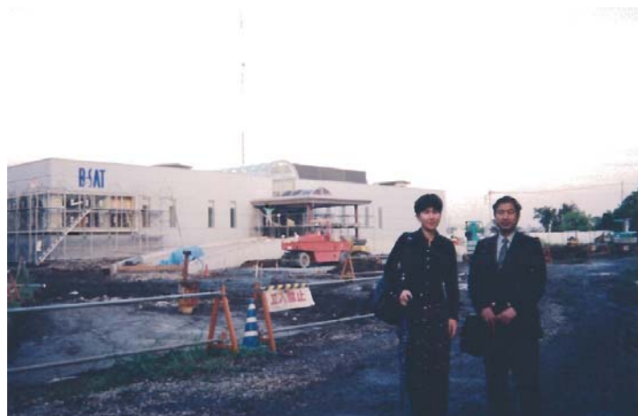
建設中の川口衛星管制センター
