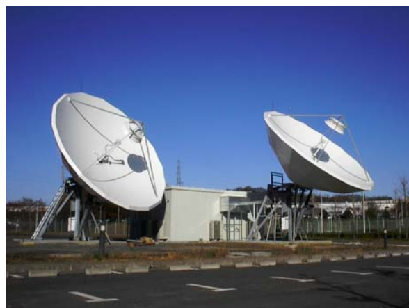
宇宙通信(株) 茨城ネットワークオペレーションセンターのCBB用送受信アンテナ
