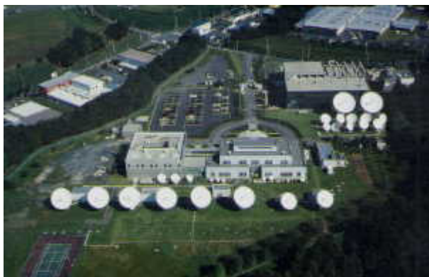
茨城衛星管制局(SPE)とSCCテレポートセンター(STC)
