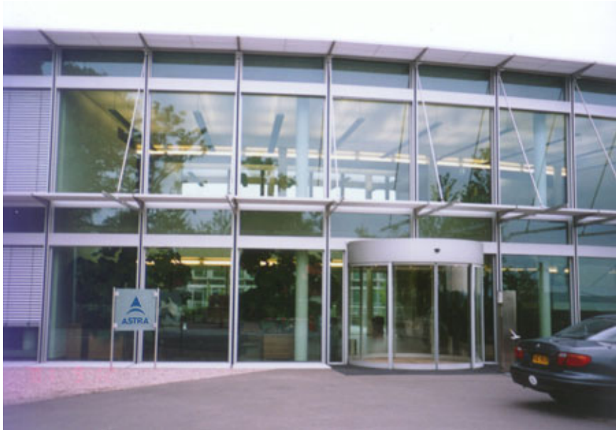
SES アストラ正面入口
