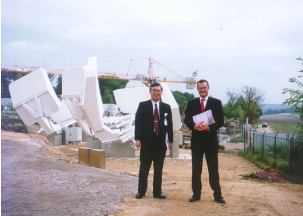
ハリウェル氏と建設中のマルチビームアンテナサイトにて
